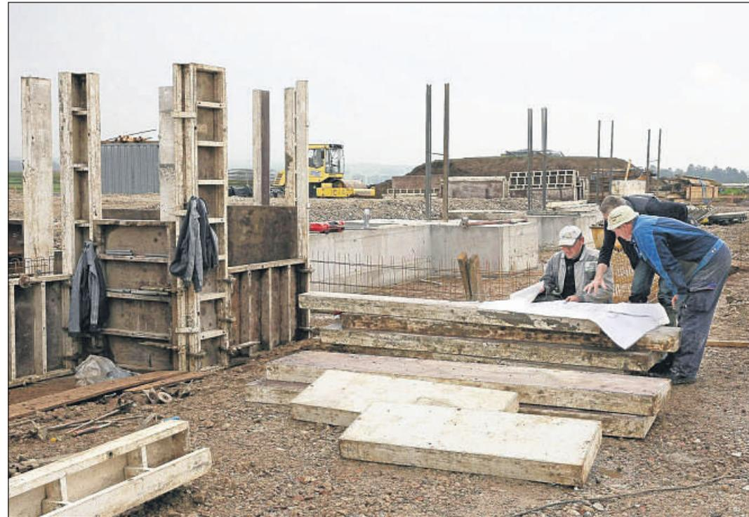
**Neubau: Wegen des schwierigen Untergrunds, der mit Kalk gefestigt werden musste, werden in Hofgeismar sehr große Fundamente für die neue Bäckerei gebaut.**
